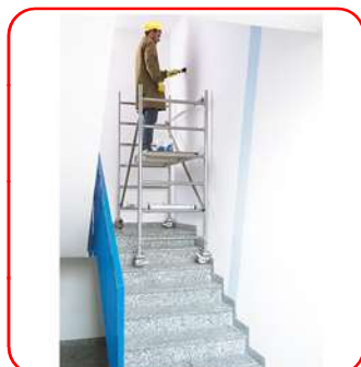
Módulo A en desnivel
