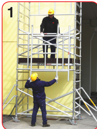
Il parapetto SAFE è in alluminio leggero e facile da maneggiare
