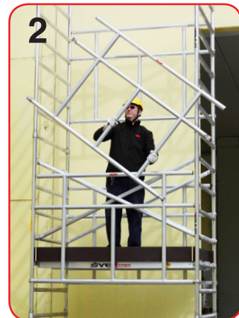
Il parapetto SAFE è in alluminio leggero e facile da maneggiare
